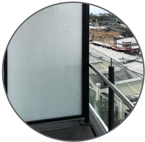
ÉCRAN SÉPARATEUR EN VERRE SEMI-GIVRÉ ET ALUMINIUM PEINT NOIR OU ÉQUIVALENT
